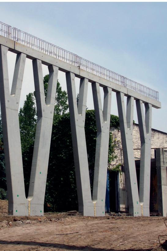
1. kép A pillérek egy ágas faszerkezetet mintáznak
